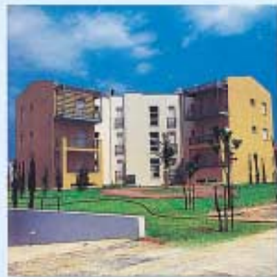
Олимпийското село (2300 апартамента) Конструктивна част: K. Liontos & Associates (STRAD & STEEL), Ел. част : LDK Consultants (FINE)
