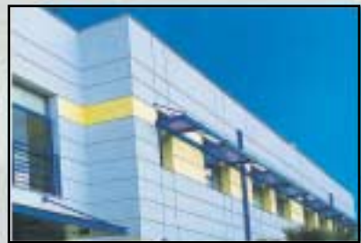
Κτίριο Doping Control (Κ. Λιόντος & Συνεργάτες)
