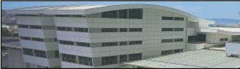
Διεθνές Κέντρο Ραδιοηλεκτρονικής (IBC) (Προμελέτες Η/Μ: Π.Ι. Ζαννής & Συνεργάτες, Οριστική μελέτη: Τρίεδρος Μελετητική ΕΠΕ (Α' Φάση, κέλυφος) ΕΛΞΙΣ Α.Ε. (Β' Φάση, εσωτερικές εγκ/σεις))
